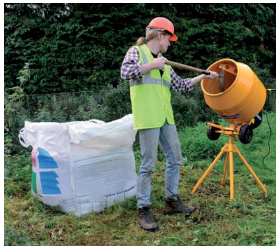
Со мешање песок, цемент и вода се добива бетон.
