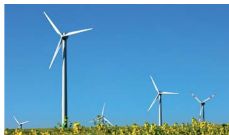
Трите лопатки на турбината ги движи ветерот. Генераторот е зад турбината.
